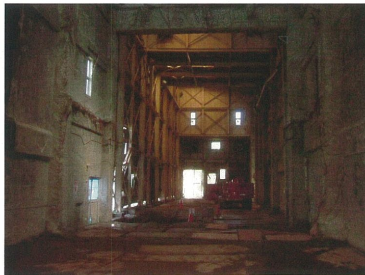
機器解体・洗浄完了
