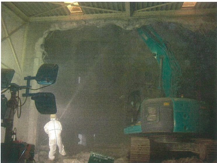
機器解体・洗浄完了
