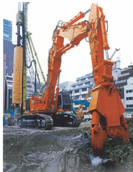
使用予定解体重機
