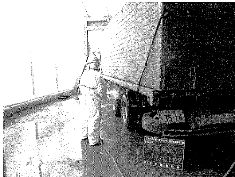
白井清掃センター解体工事
