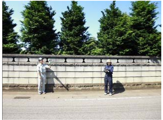
写真 3-29 クリーンセンター周辺(No. 26)
