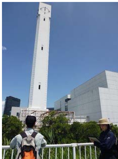
写真 3-3 クリーンセンター外周(C)
